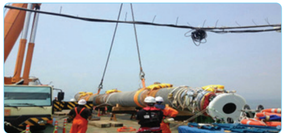
[그림 5] 울산해저면 새로운 원유송유관 설치 및 기존 배관과 연결
