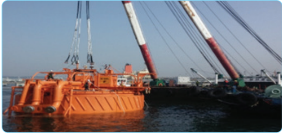
[그림 3] SK/S-OIL의 원유하역시설(SPM) 이설공사
