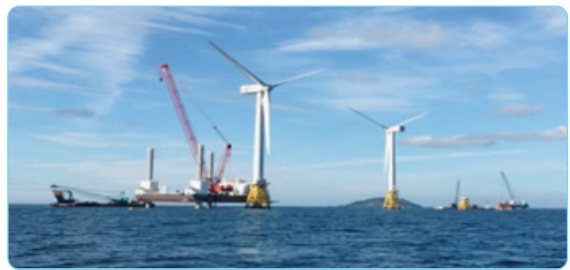
[그림 1] 탐라해상풍력발전단지 하부구조물(자켓) 및 풍력발전기 설치
