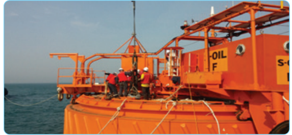
[그림 3] SK/S-OIL의 원유하역시설(SPM) 이설공사
