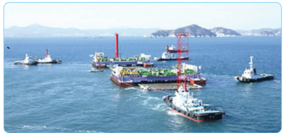
[그림 4] 부산-거제간 침매터널 설치공사
