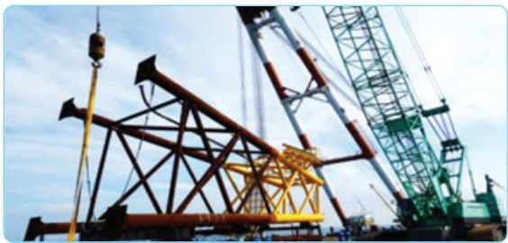
[그림 1] 탐라해상풍력발전단지 하부구조물(자켓) 및 풍력발전기 설치
