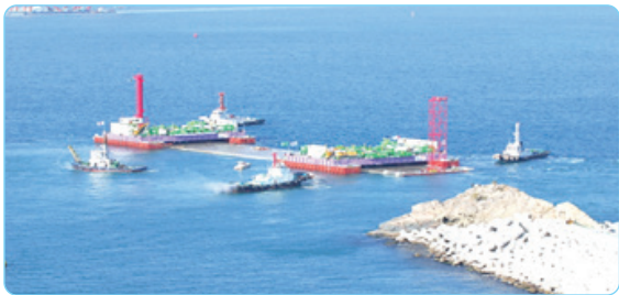
[그림 4] 부산-거제간 침매터널 설치공사
