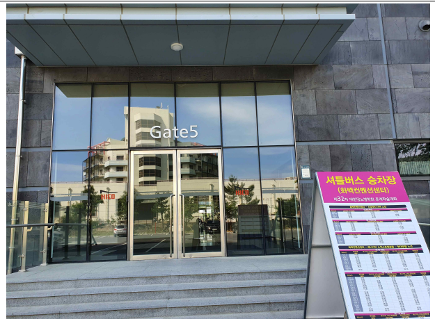
Gate 5 안내배너 설치 예시
